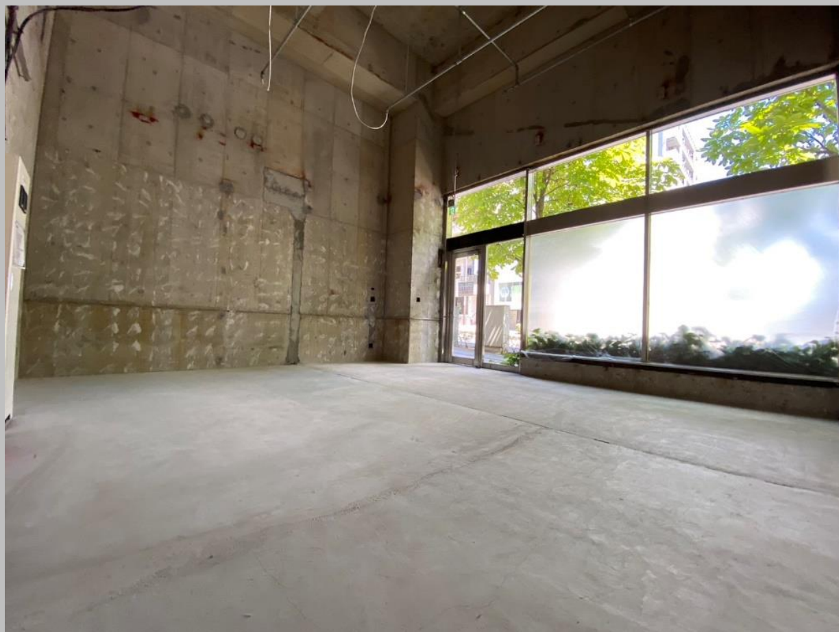
地下2階(2)区画貸室
