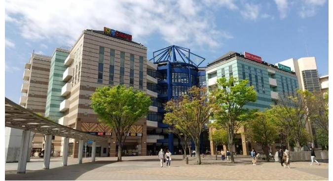
港北東急SC(駅前広場)
