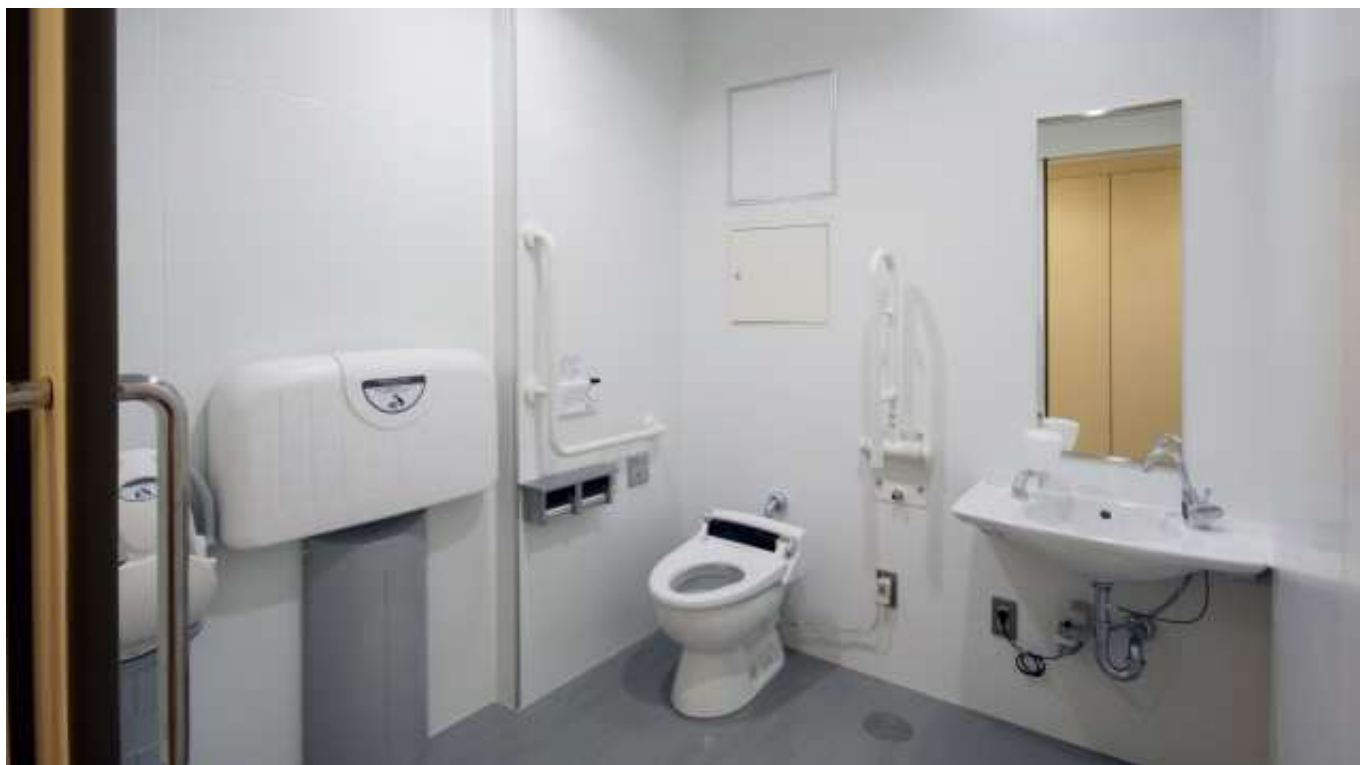
ー多目的トイレー
