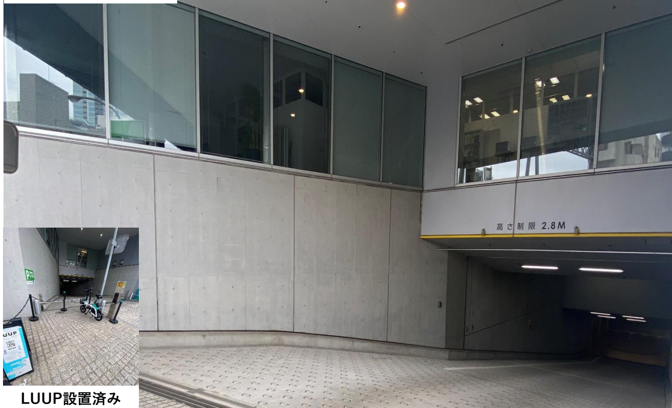
駐車場入口 明治通りから入れます
