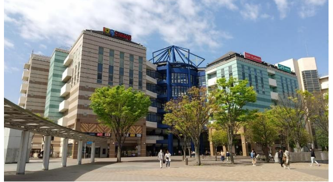
港北東急SC(駅前広場)
