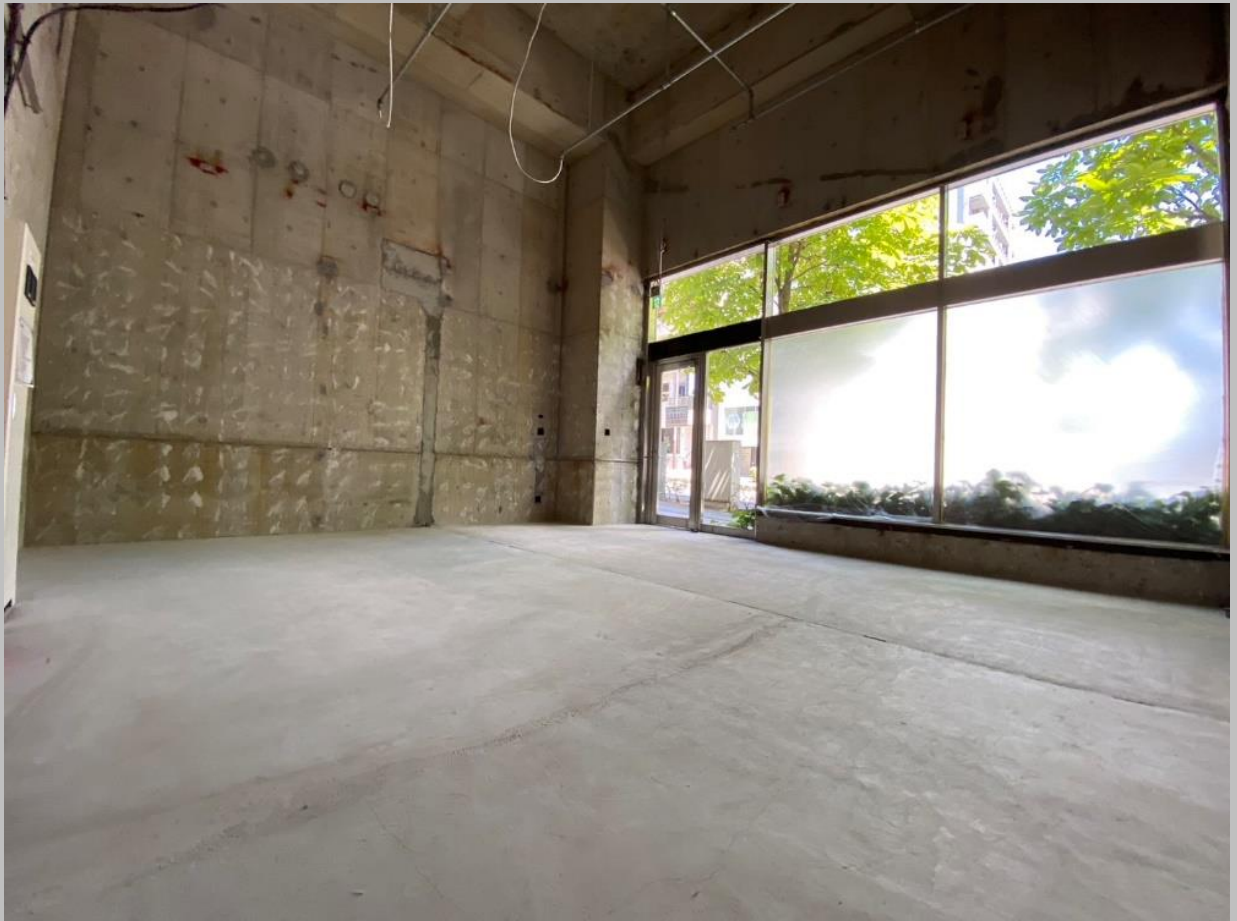
地下2階(2)区画貸室
